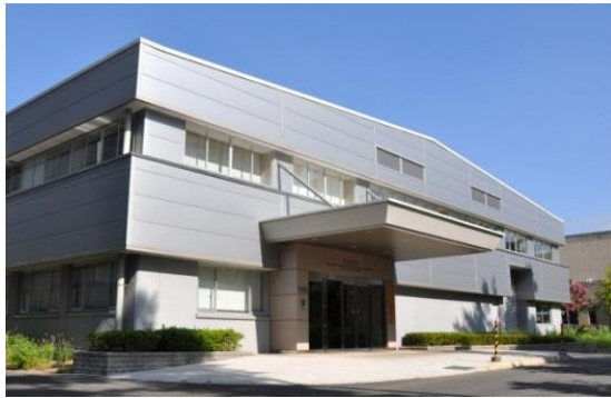
ICHARM Building at PWRI 土木研究所 ICHARM 棟
